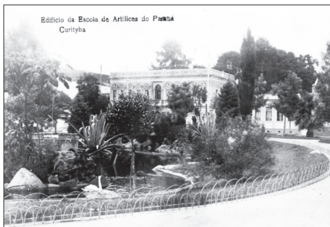
Figura 1 – Fachada da Escola de Aprendizizes Artífices do Paraná, situada na Praça Carlos Gomes, Curitiba – PR.
