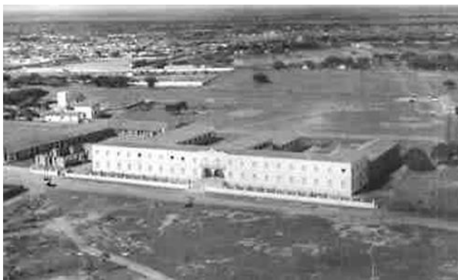
Figura 1 – Prédio do CDSL (1956)
