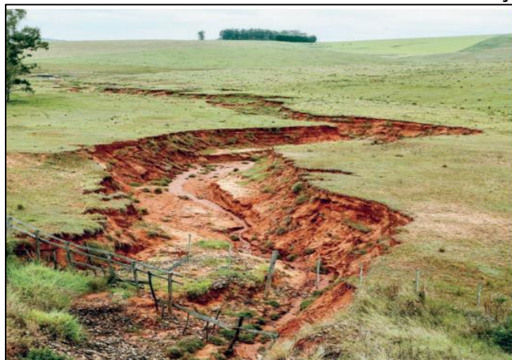
Figura 4 - Efeito de erosão no solo conhecida como voçoroca
