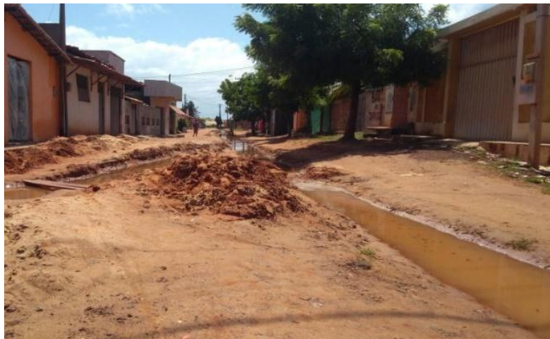
Figura 8 - Valas para o escoamento da água.
