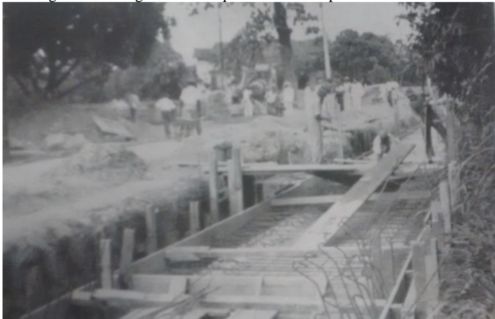
Figura 4: Córrego no Méier que fora coberto por concreto armado.
