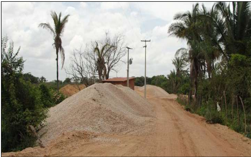
Figura 4 – Fotografia mostrando local de lavagem e depósito de seixos no bairro Pedra Mole, na Zona Leste de Teresina-PI
