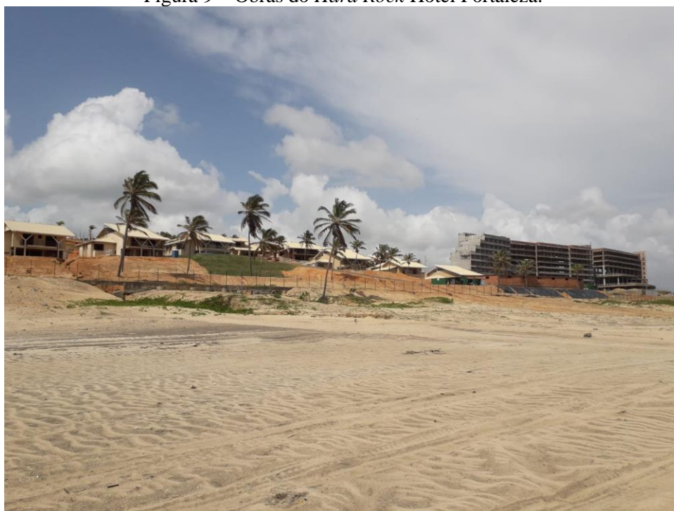
Figura 9 – Obras do Hard Rock Hotel Fortaleza.
